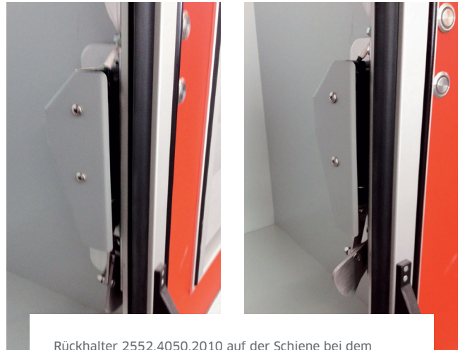
Rückhalter 2552.4050.2010 auf der Schiene bei dem Stangengriffverschluss.
