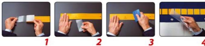
Temperaturbereich während der Verklebung: +10 °C bis +38 °C. Die Oberfläche gründlich mit Wasser und einem milden Reinigungsmittel reinigen.
