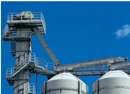
A4-Einsatz im Industrie- und Chemieanlagenbau
