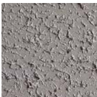
V5 Rutschfester Fließboden mit besandeter Versiegelung Marocoat
